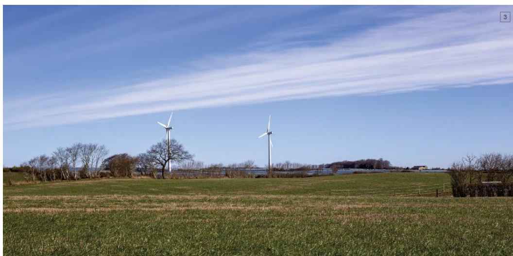
Figur 7-31. Fotostandpunkt 3 fra Lakkendrupvej, ca. 250 meter syd for anlægget, inden den nye afskærmende vegetation er vokset op.
